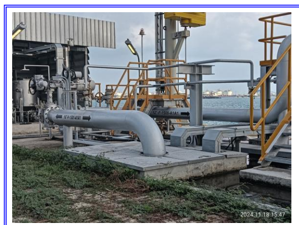
รูปที่ 3-40 คันคอนกรีตและบ่อพัก (sump)
