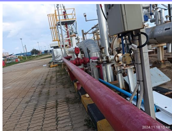
รูปที่ 3-2 Curb ป้องกันการรั่วไหลของสารเคมี
