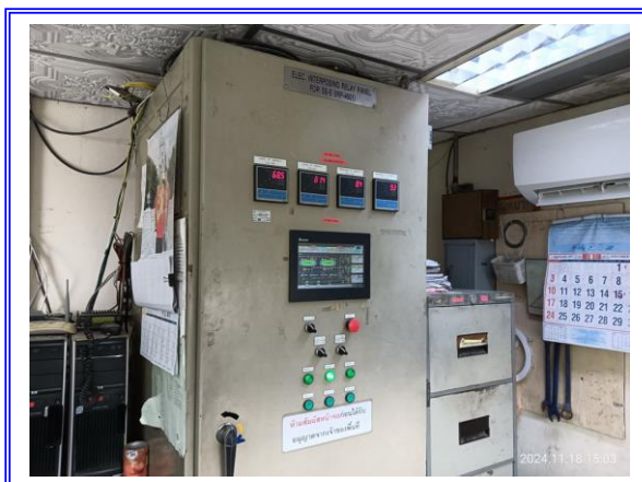
รูปที่ 3-30 ระบบ DCS ที่ Control Room ควบคุมการสูบน้ำถ่ายบริเวณท่าเรือ
